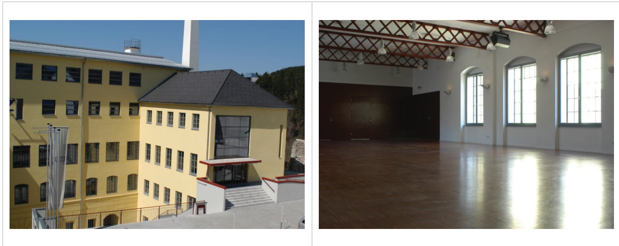
Abbildung 9: Sanierung Vonwillerareal ( www.architektur-arkade.at )
